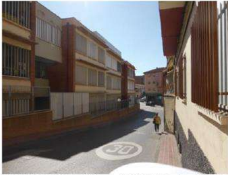
4. Aceras impracticables o inexistentes en acceso a equipamiento y al enclave que permite la comunicación vertical con el centro histórico.
