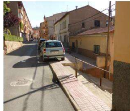
7. Acera mínima con riesgo de caída y escalera que prácticamente desemboca en la calzada.
